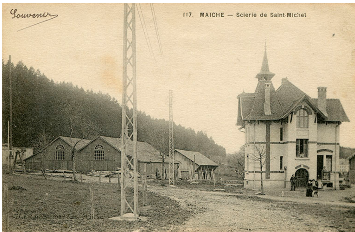
117. Maîche - Scierie de Saint-Michel [scierie et villa depuis l'est], 1er quart 20e siècle.
