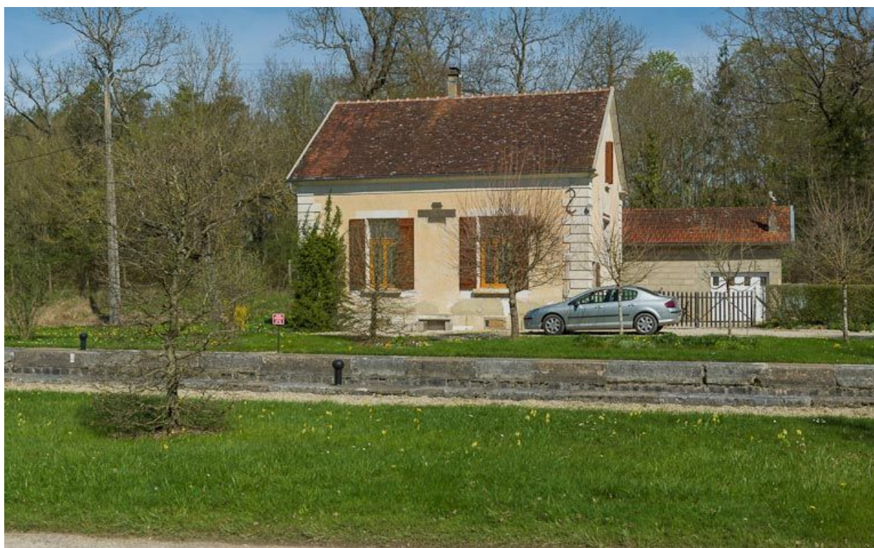
Vue de face de la maison éclusière.
