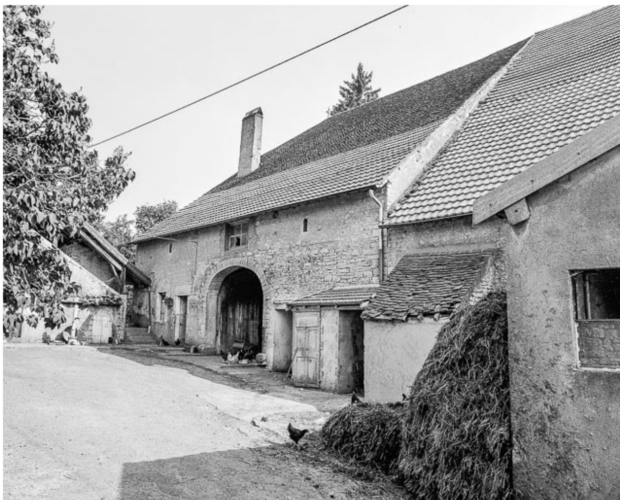
Bâtiment de droite : façade antérieure.
