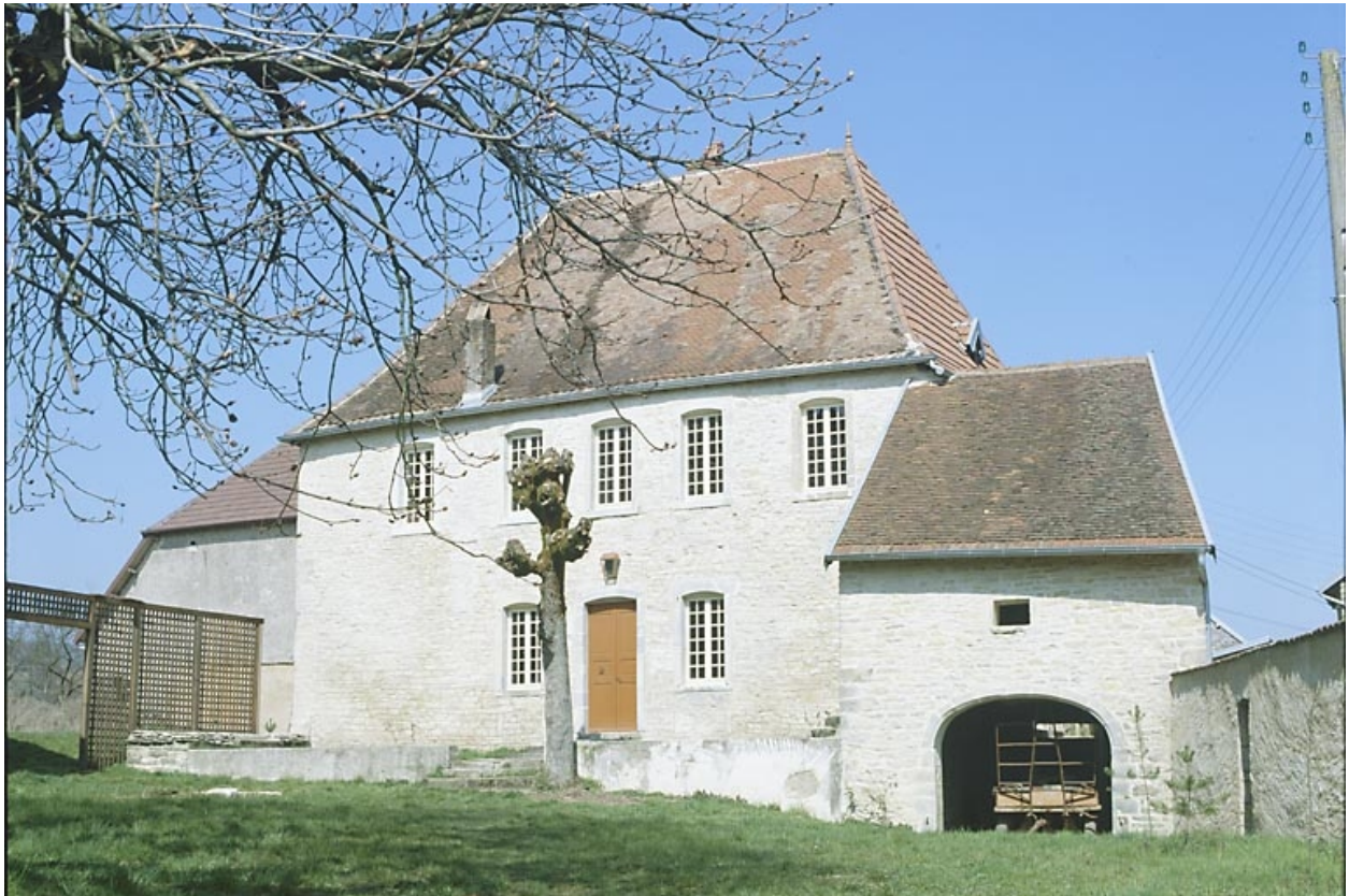
Vue d'ensemble éloignée de la maison d'habitation.
