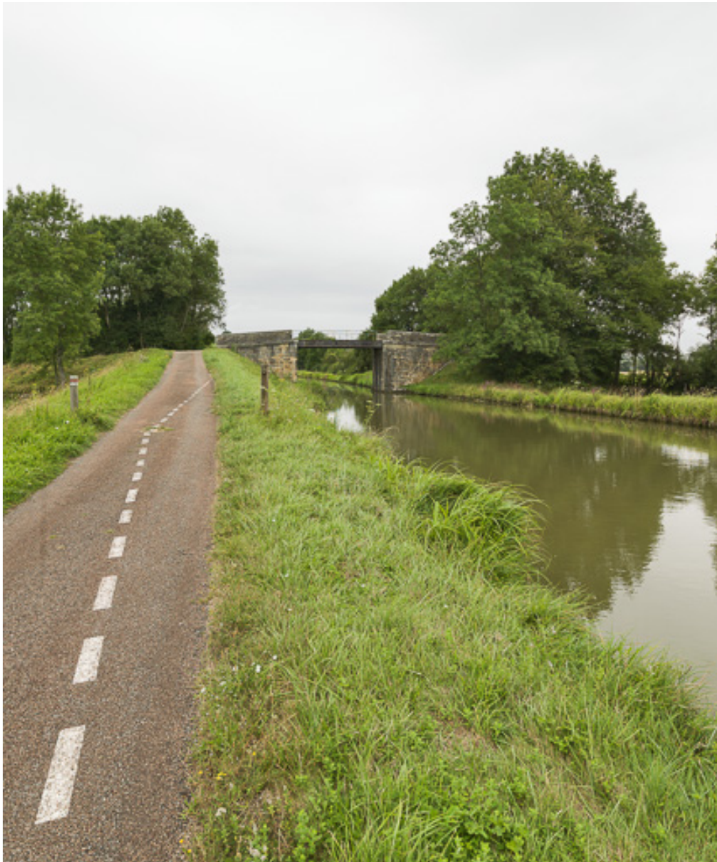
Vue d'ensemble du pont et du site.
