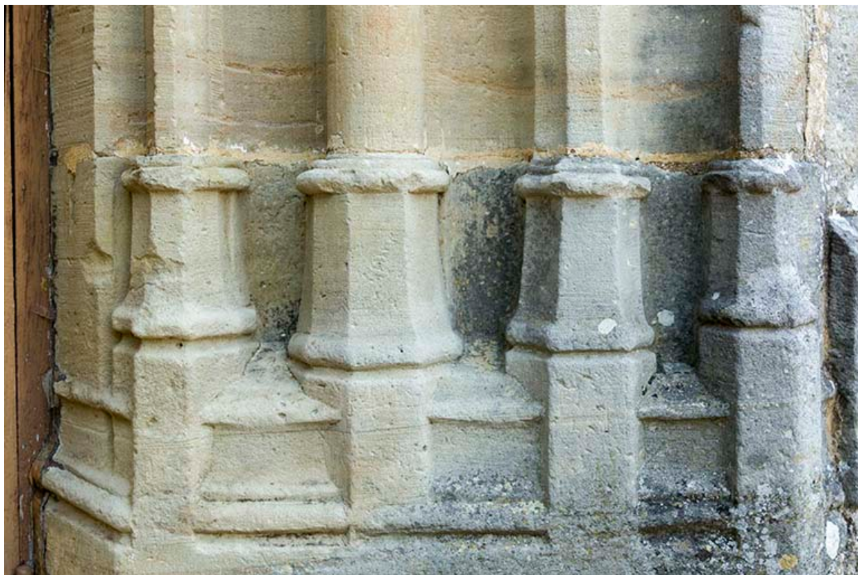
Détail de la base du piedroit droit.
