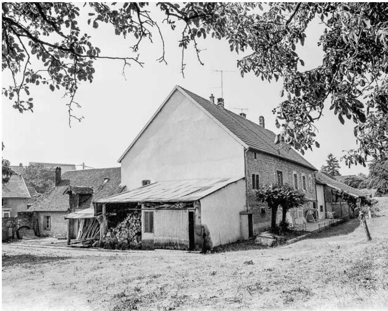
Maison cadastrée 1973 AB 11 située rue d'Aval à Chenevrey : façades postérieure et latérale droite.
