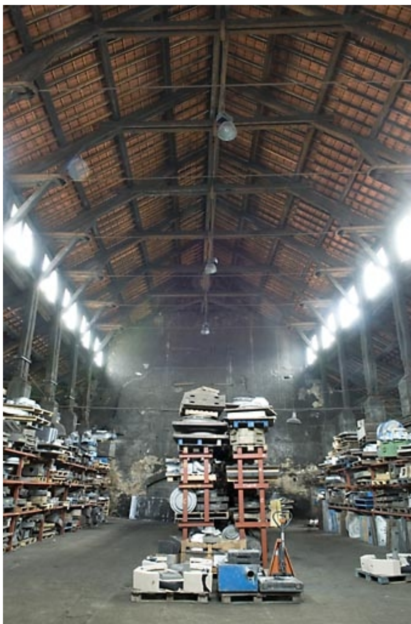
Atelier de fonderie. Vue intérieure.
