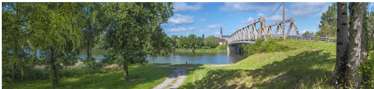
Vue d'ensemble, rive gauche.
