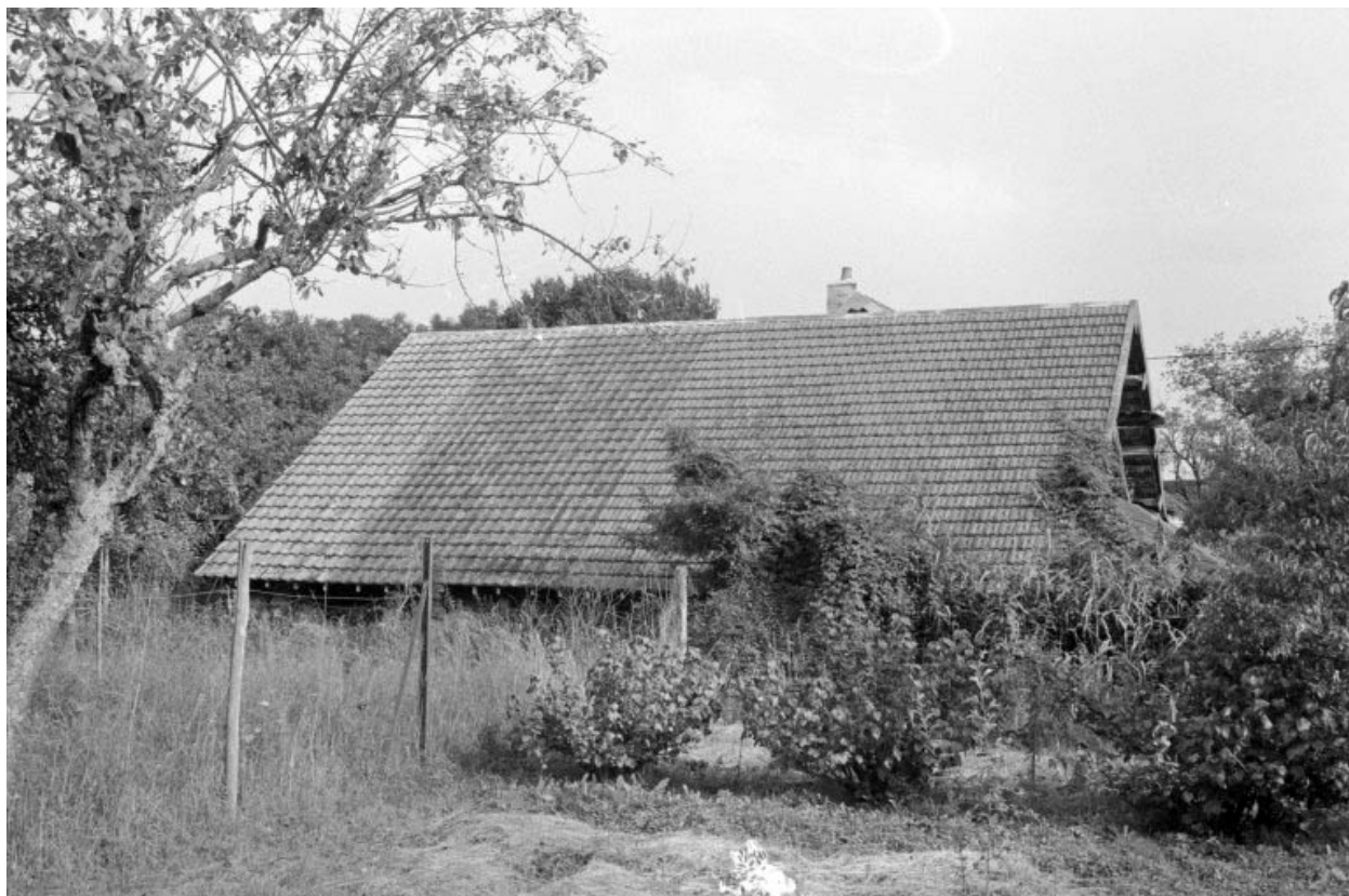
Halle de séchage (C), depuis le nord.
