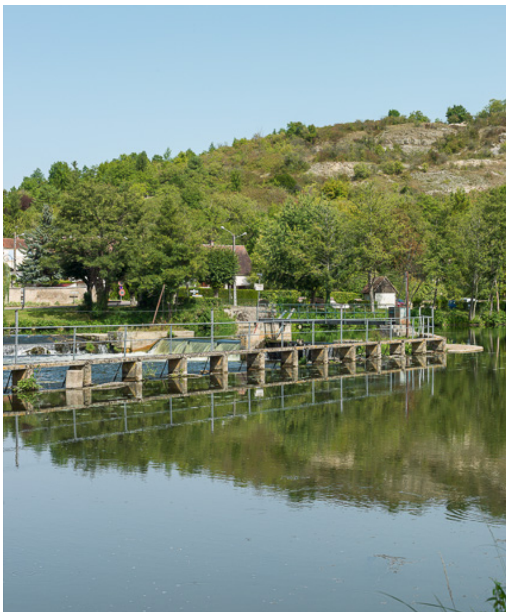
Vue du barrage.
