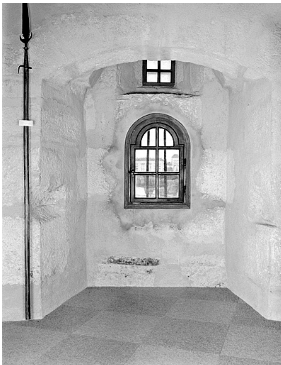
Tour Henriette. Fenêtre du troisième niveau.
