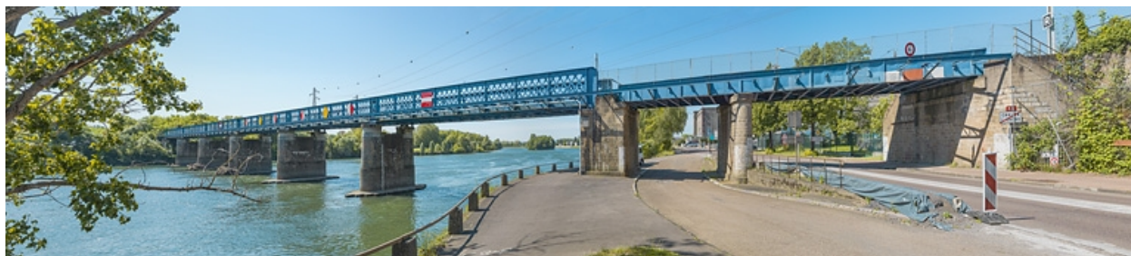
Le viaduc vu d'amont.
