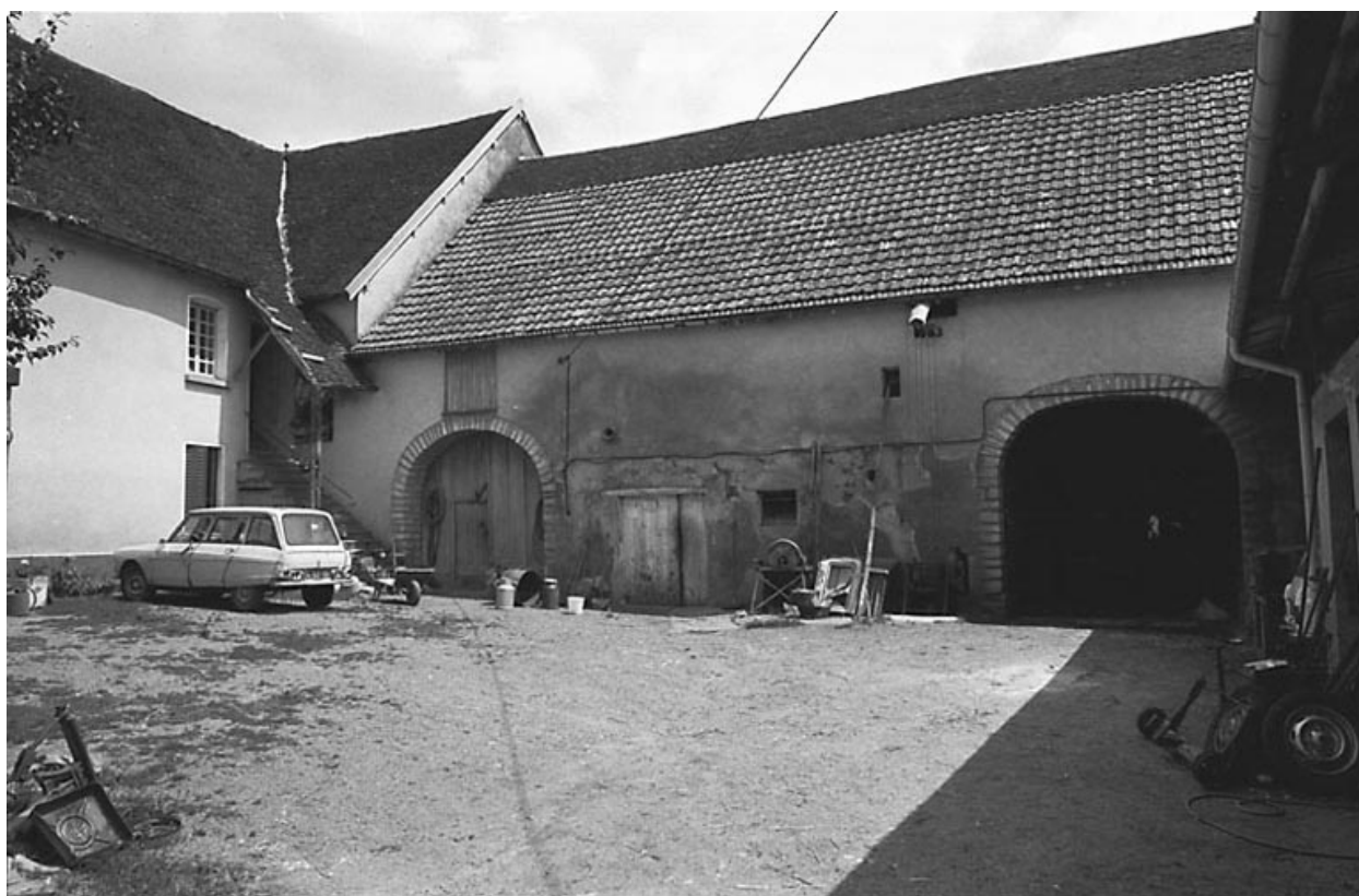
Vue des bâtiments agricoles dans la cour.
