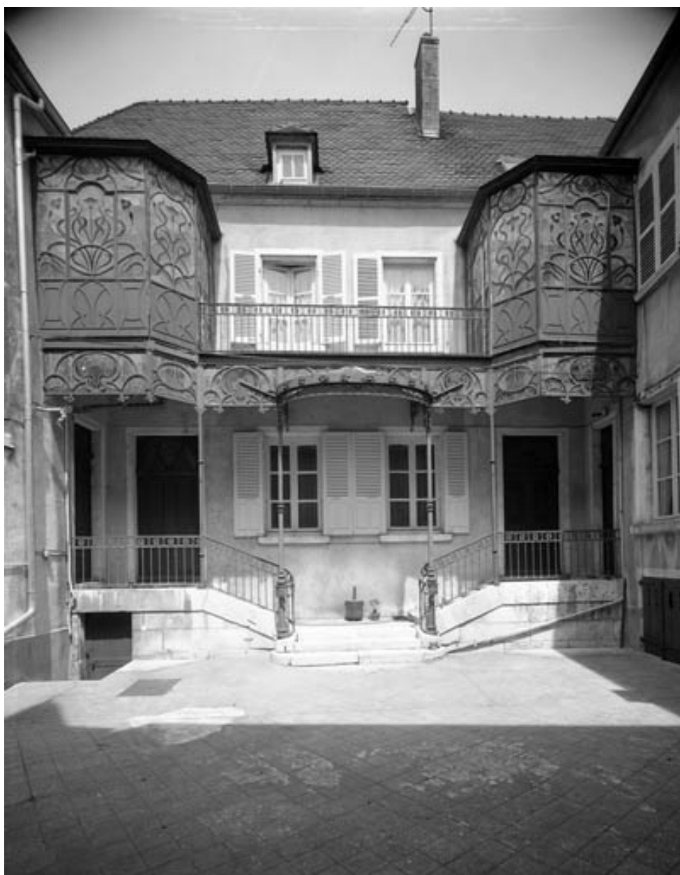
Façade antérieure sur cour, de face.
