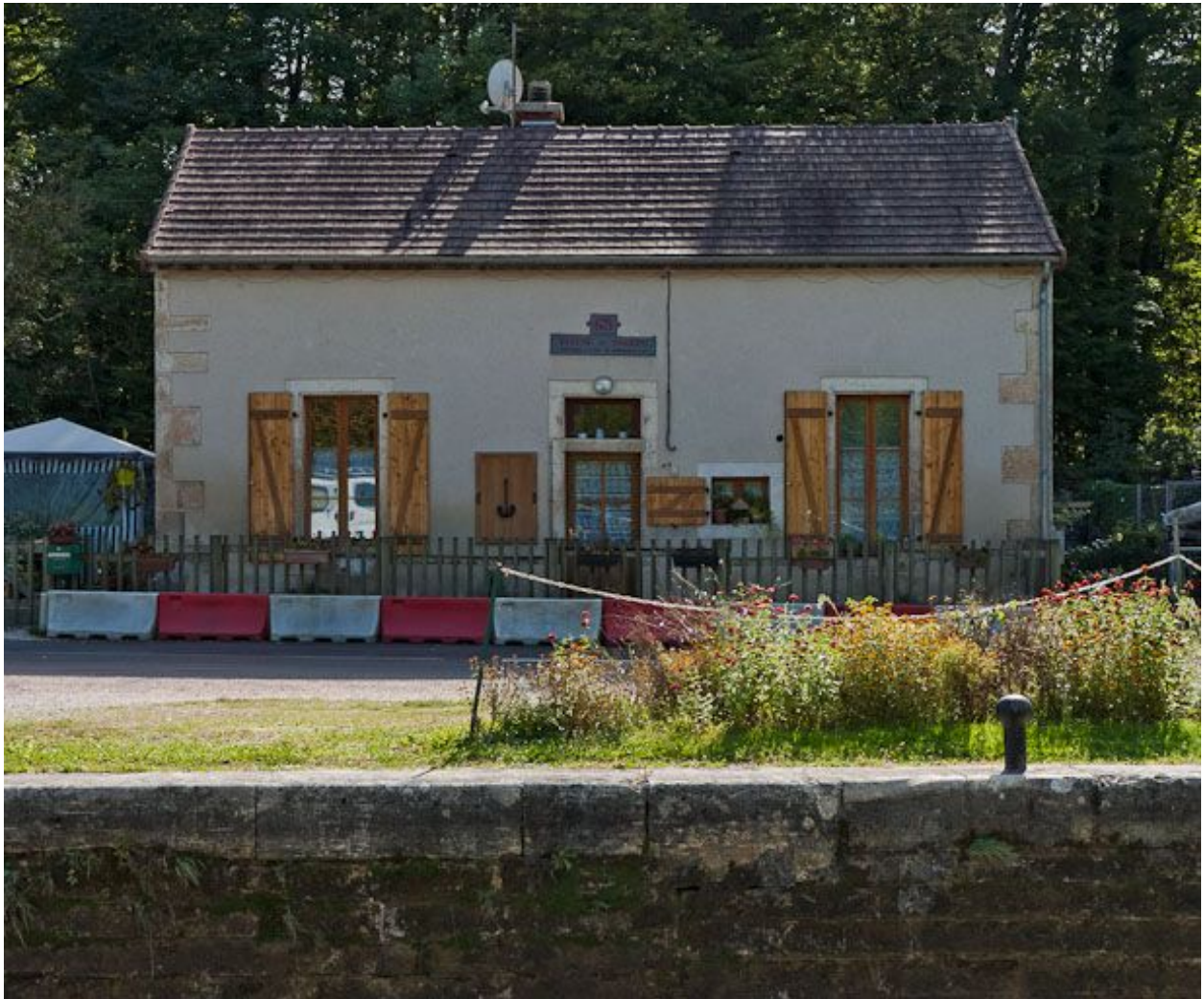
Vue de face de la maison éclusière.
