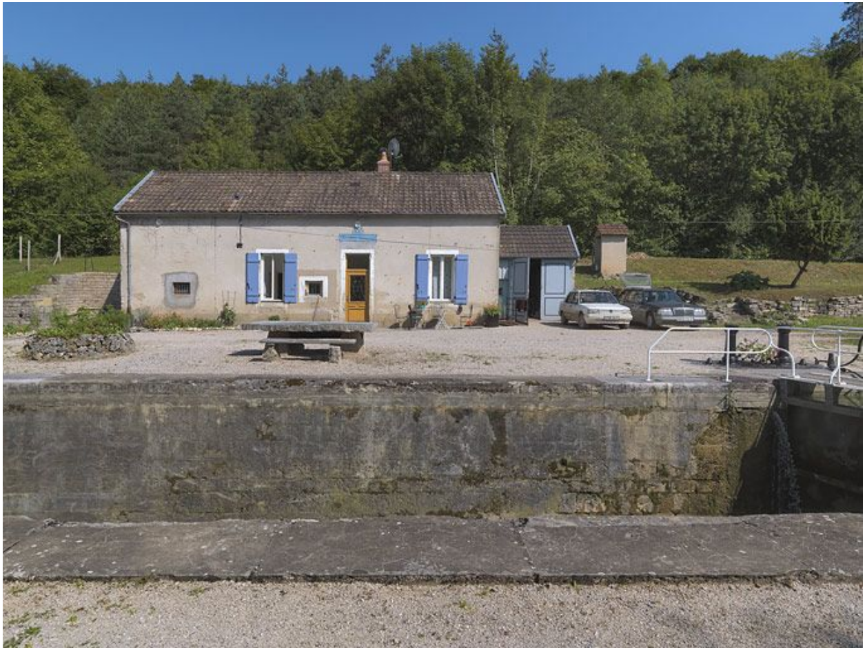
Maison éclusière de face.
