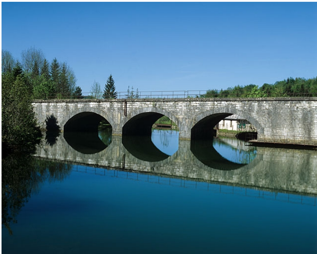
Viaduc : élévation orientale, depuis le nord-est.
