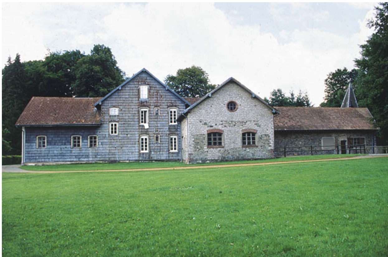
Façade postérieure de la ferme.
