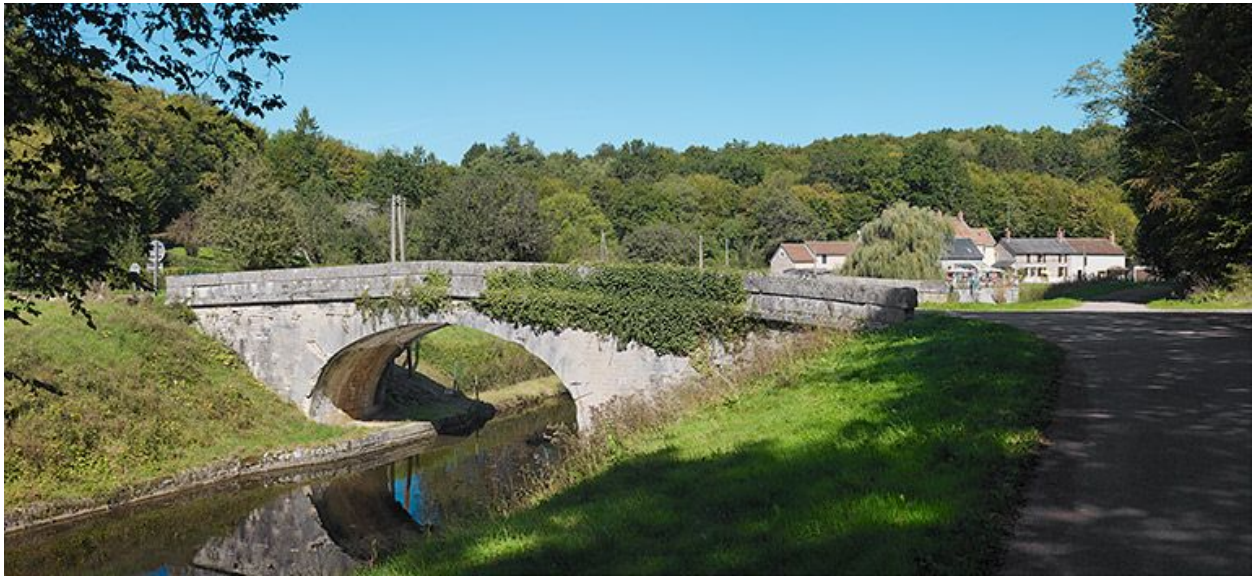
Vue d'ensemble du pont.
