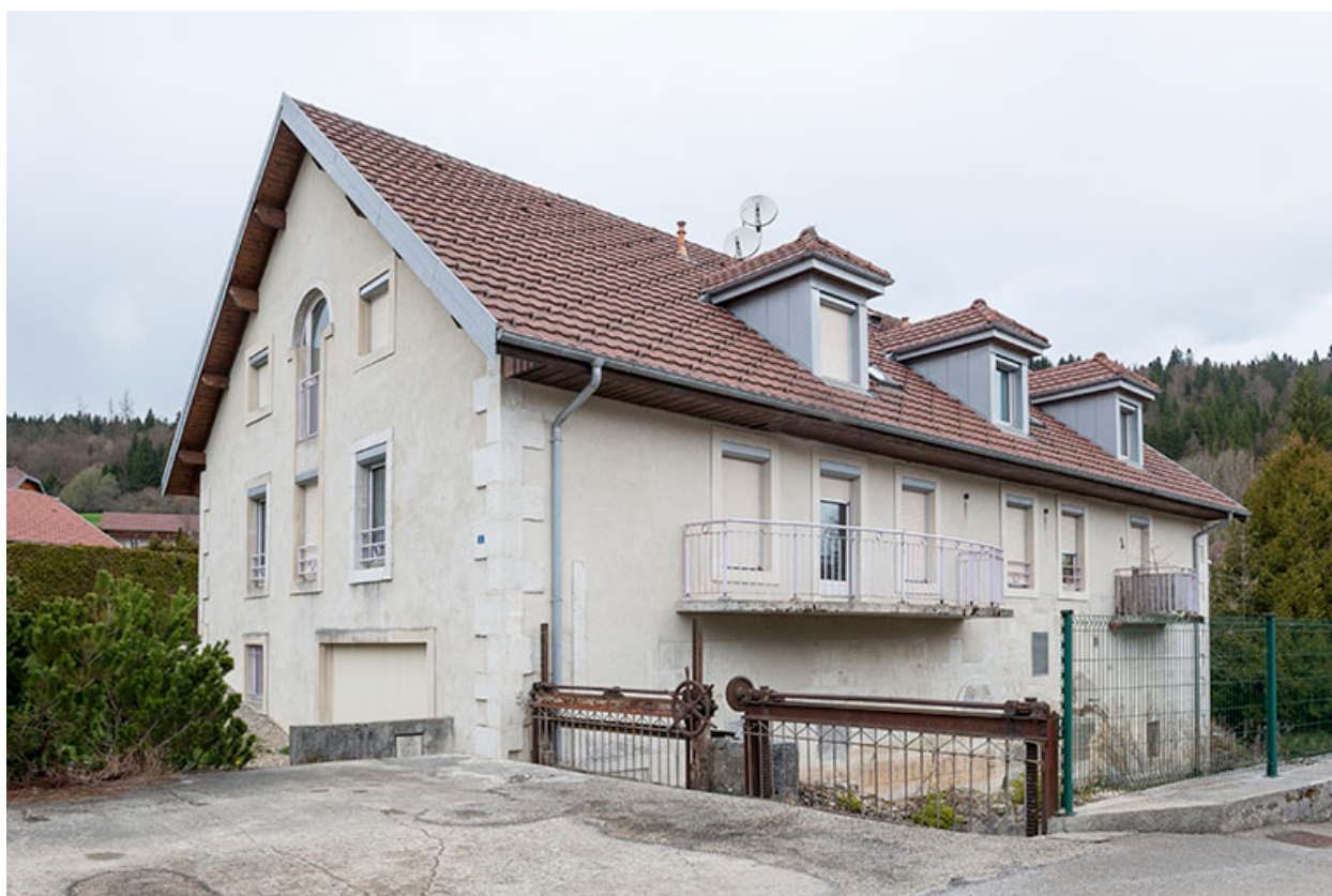
Vue depuis le sud-est.
