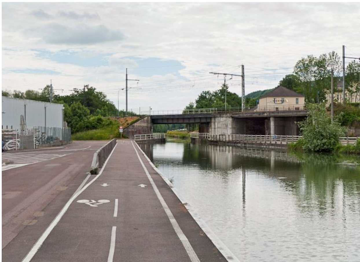
Vue d'ensemble du pont.
