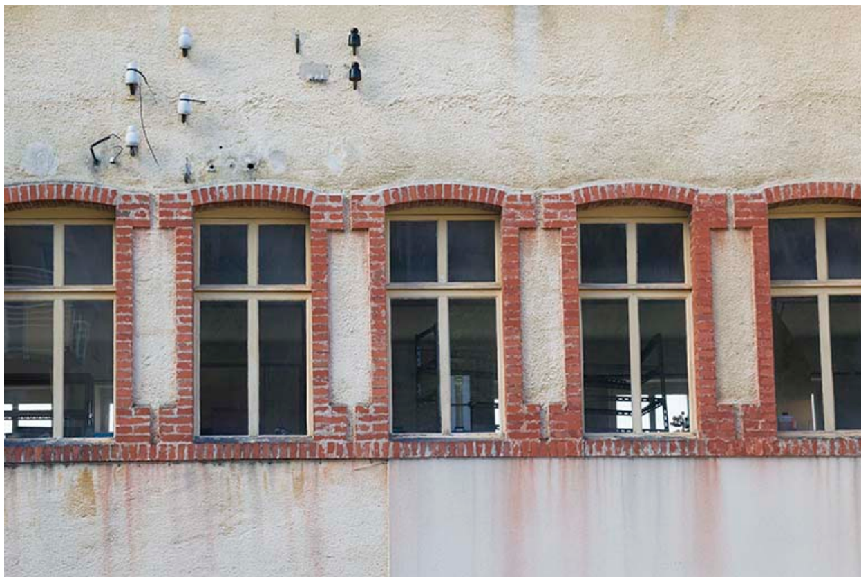
Usine, façade postérieure : fenêtres multiples.
