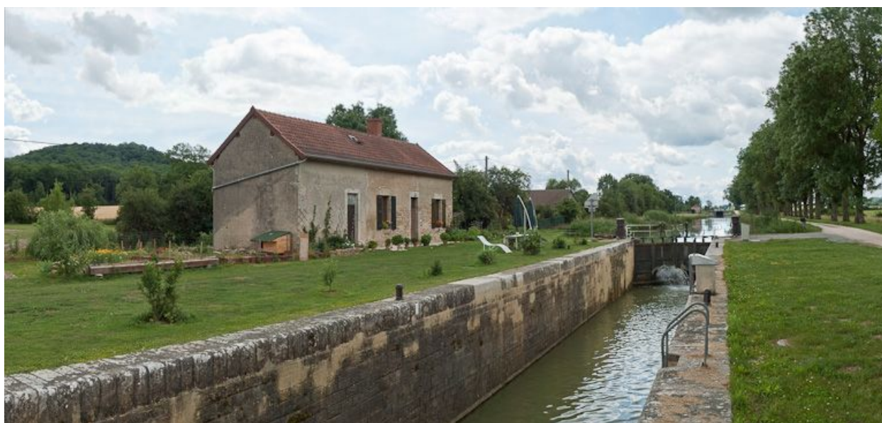
Vue d'ensemble du site d'écluse.
