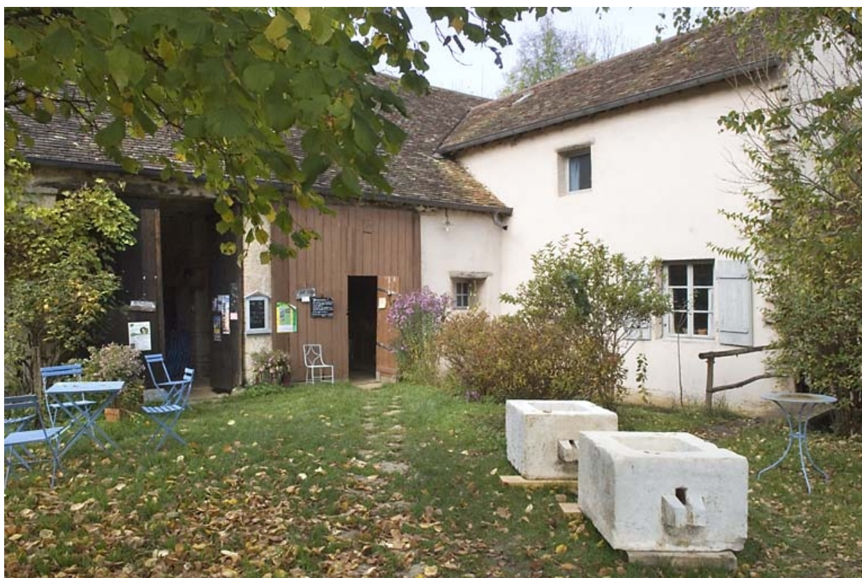
Façade est du moulin et logement.
