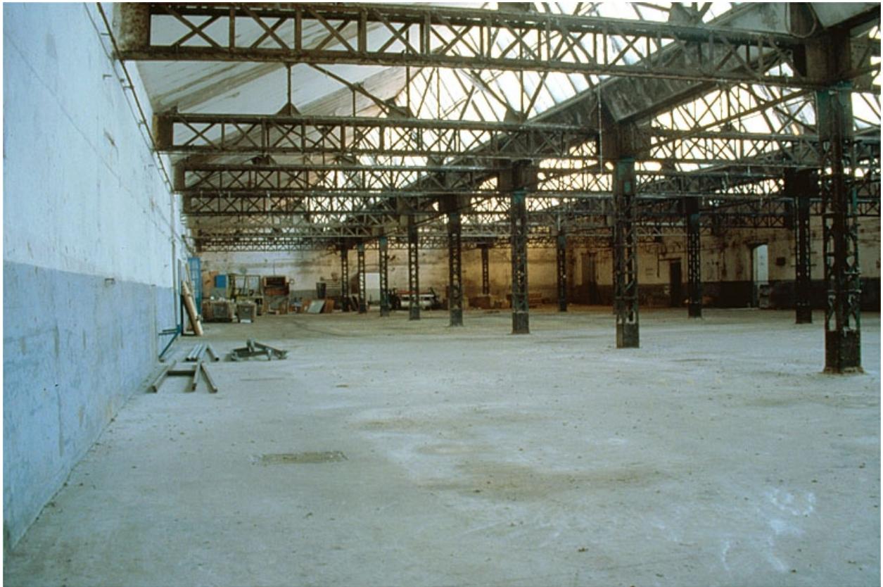
Atelier de fabrication (1), depuis l'angle sud-est. La première porte à droite est l'ancienne entrée principale de l'usine.
