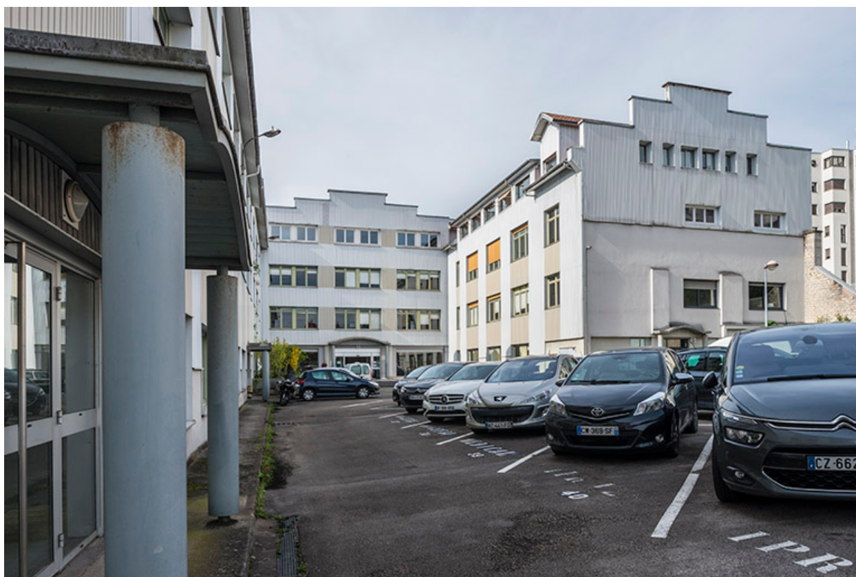
Bâtiment nord depuis la cour.
