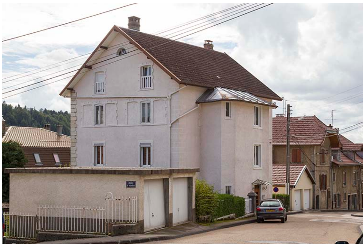
Façades antérieure et latérale gauche.
