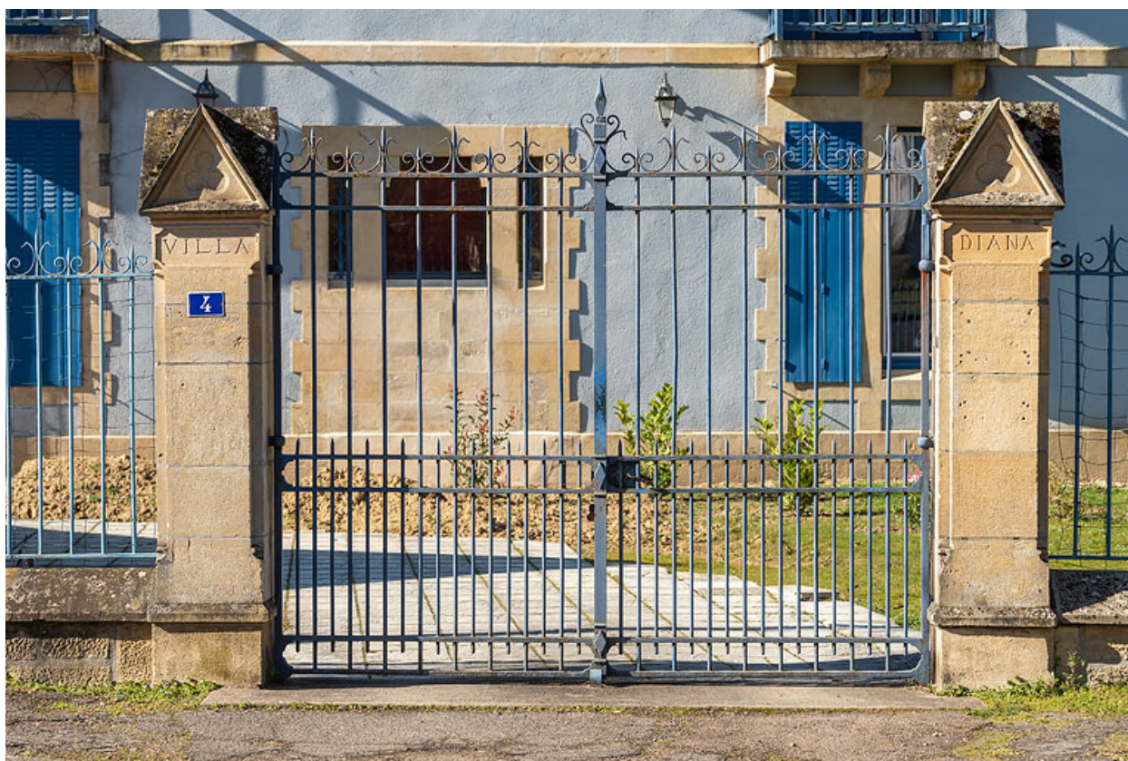
Grille et portail sur l'avenue.
