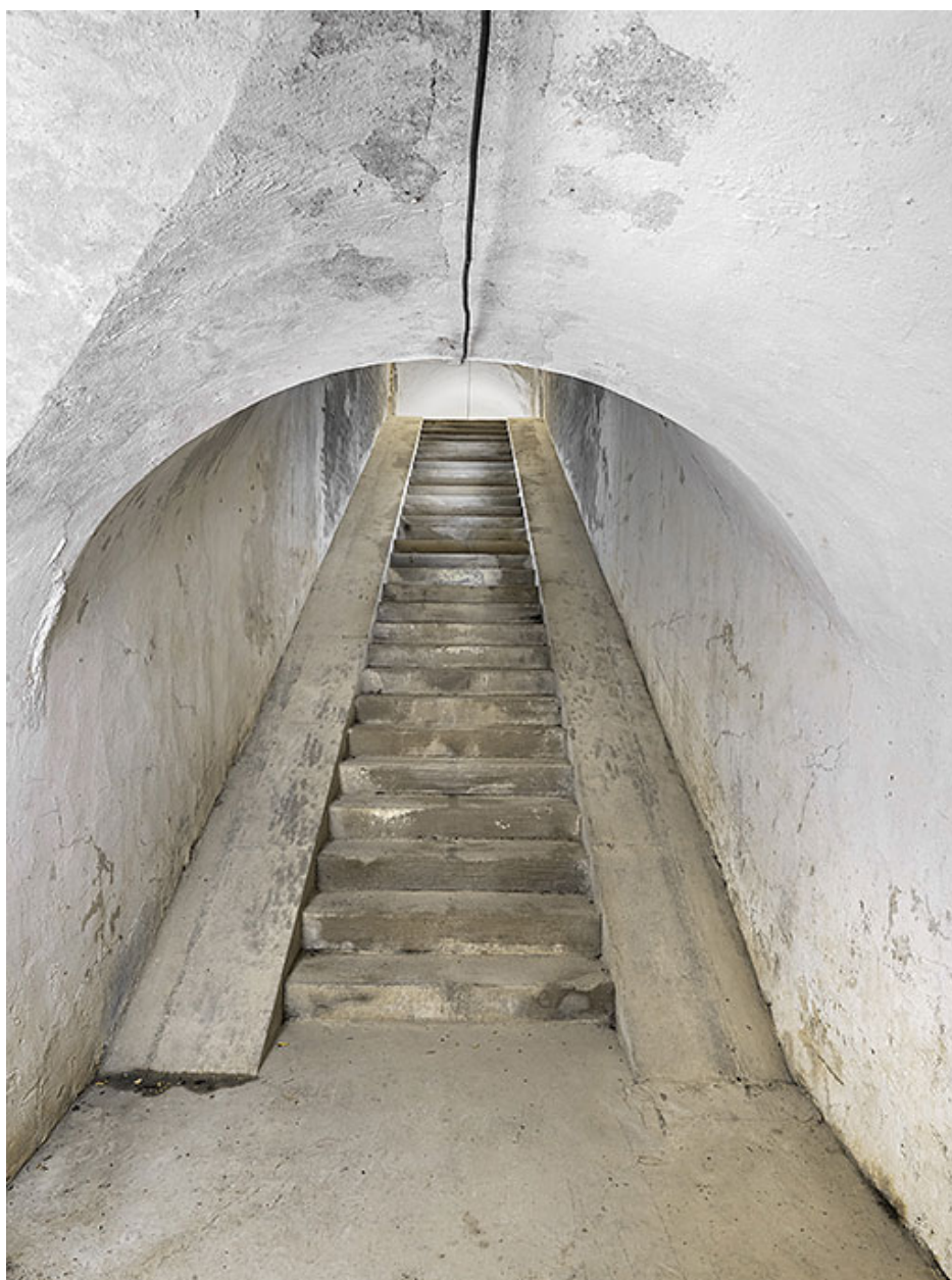
Le fort d'Hauteville : escalier-rampe vers la caponnière double du front d'attaque.
