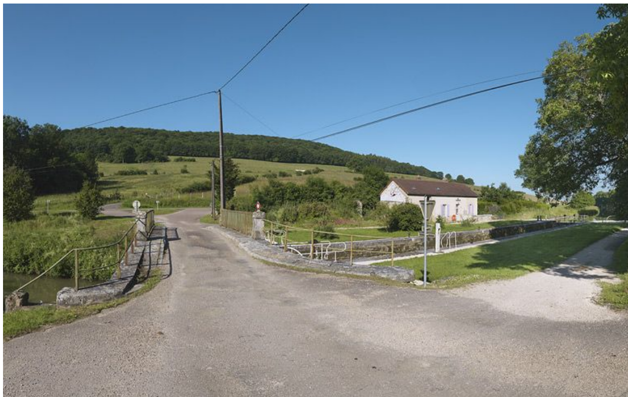
Site d'écluse vu d'aval.
