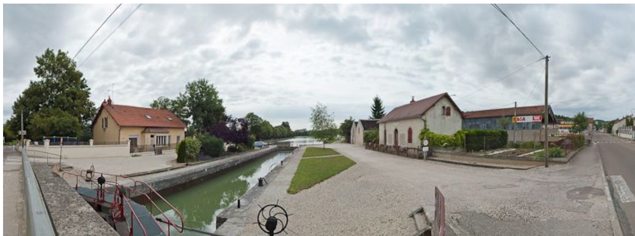
Vue d'ensemble du site d'écluse.
