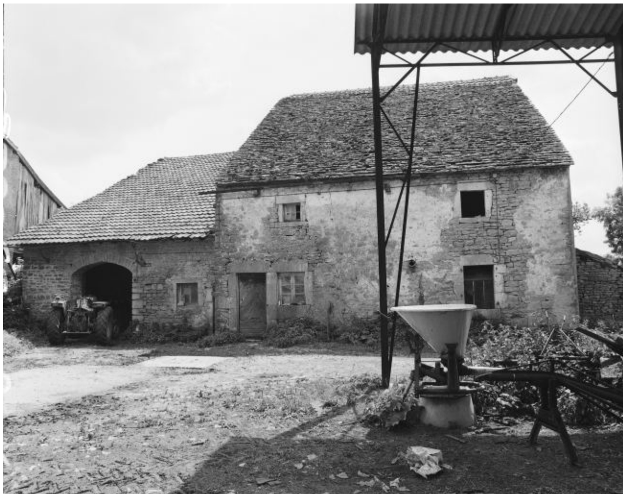
Ferme située rue de l'Oratoire.
