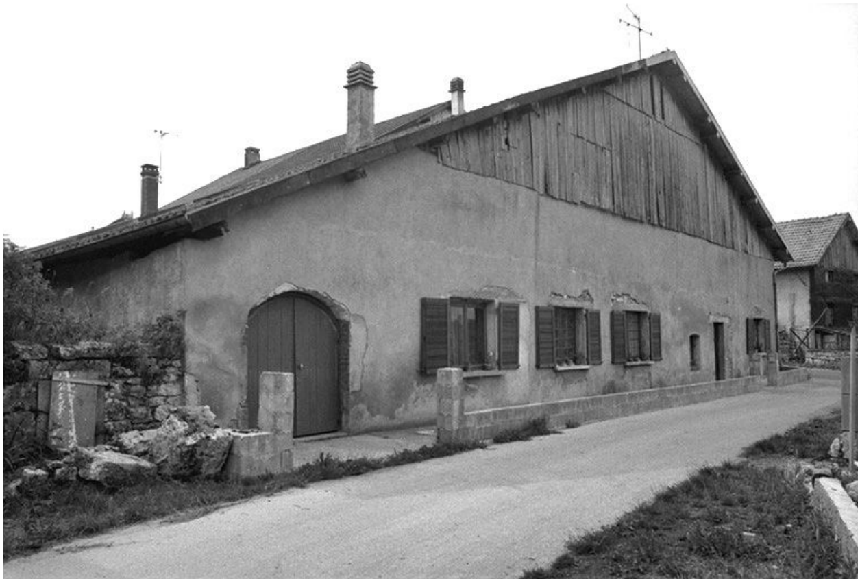
Ferme située 10 rue du Chalet : façade antérieure.
