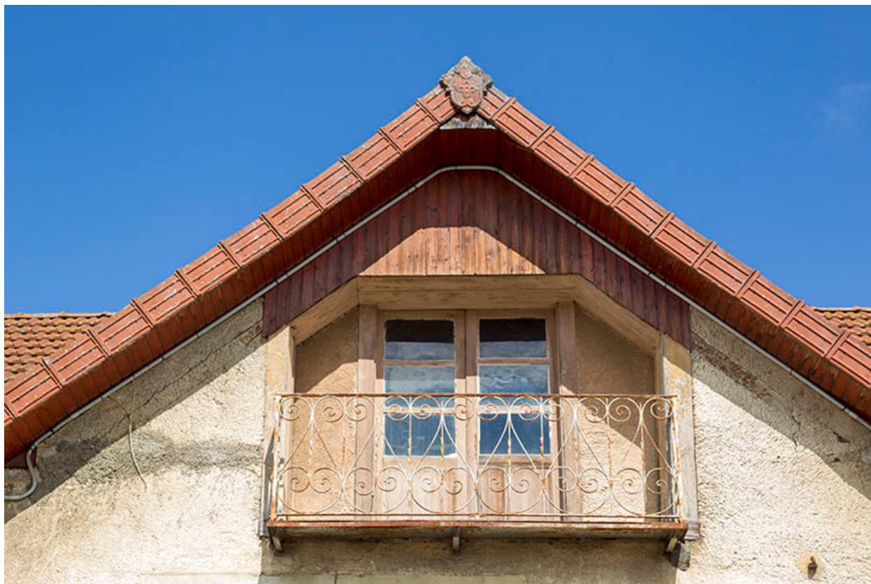
Façade antérieure : lucarne-pignon de l'étage en surcroît.
