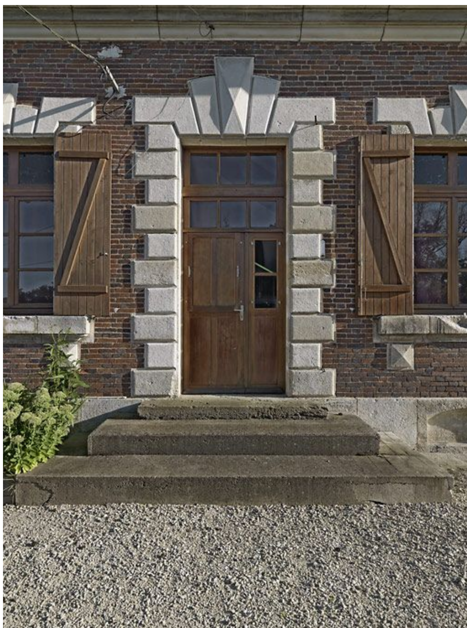
Maison éclusière : porte arrière.
