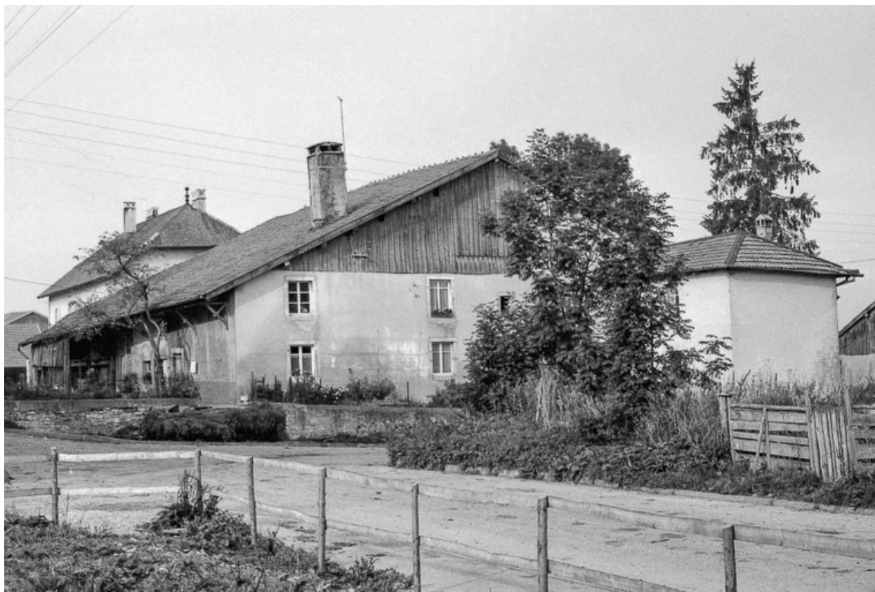
Ferme : façades antérieure et latérale droite.
