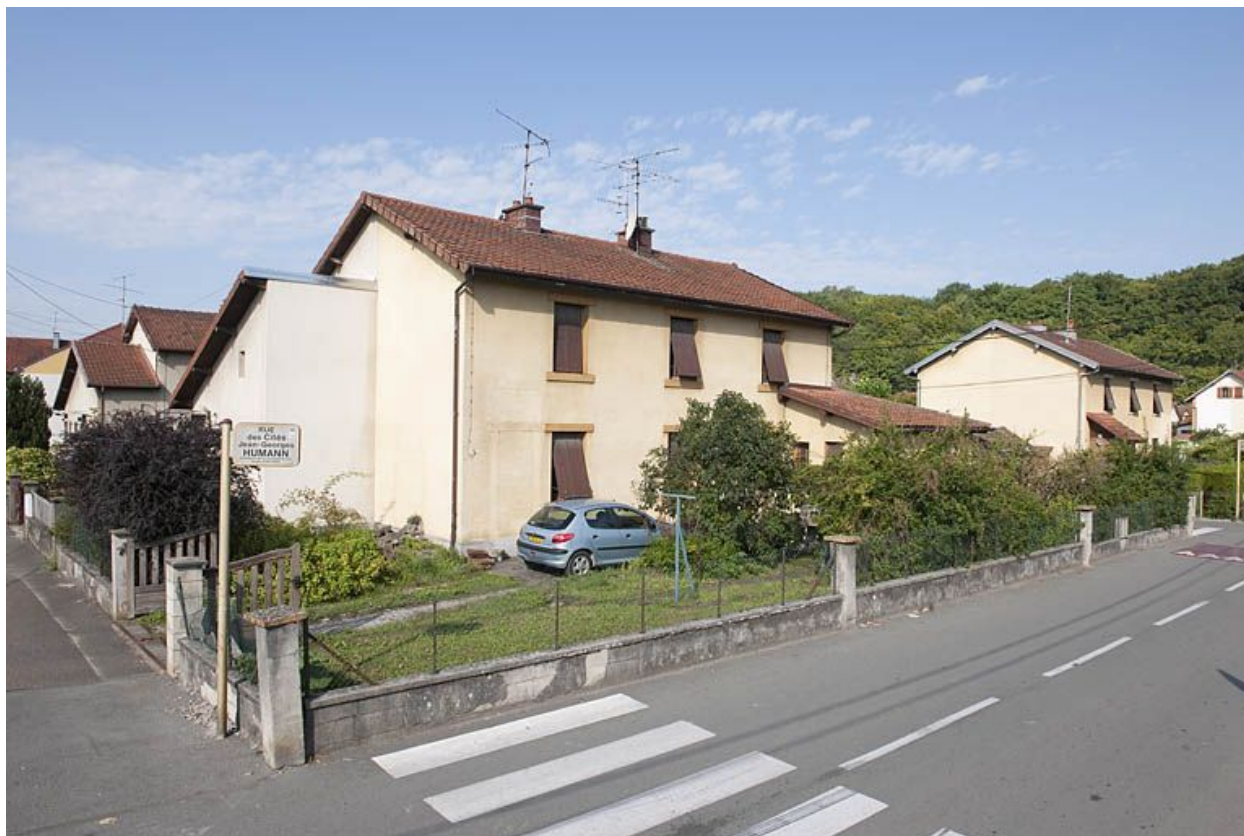
Habitations à 2-3 logements. Vue d'ensemble.
