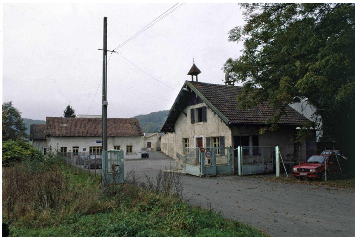
Entrée de l'usine.
