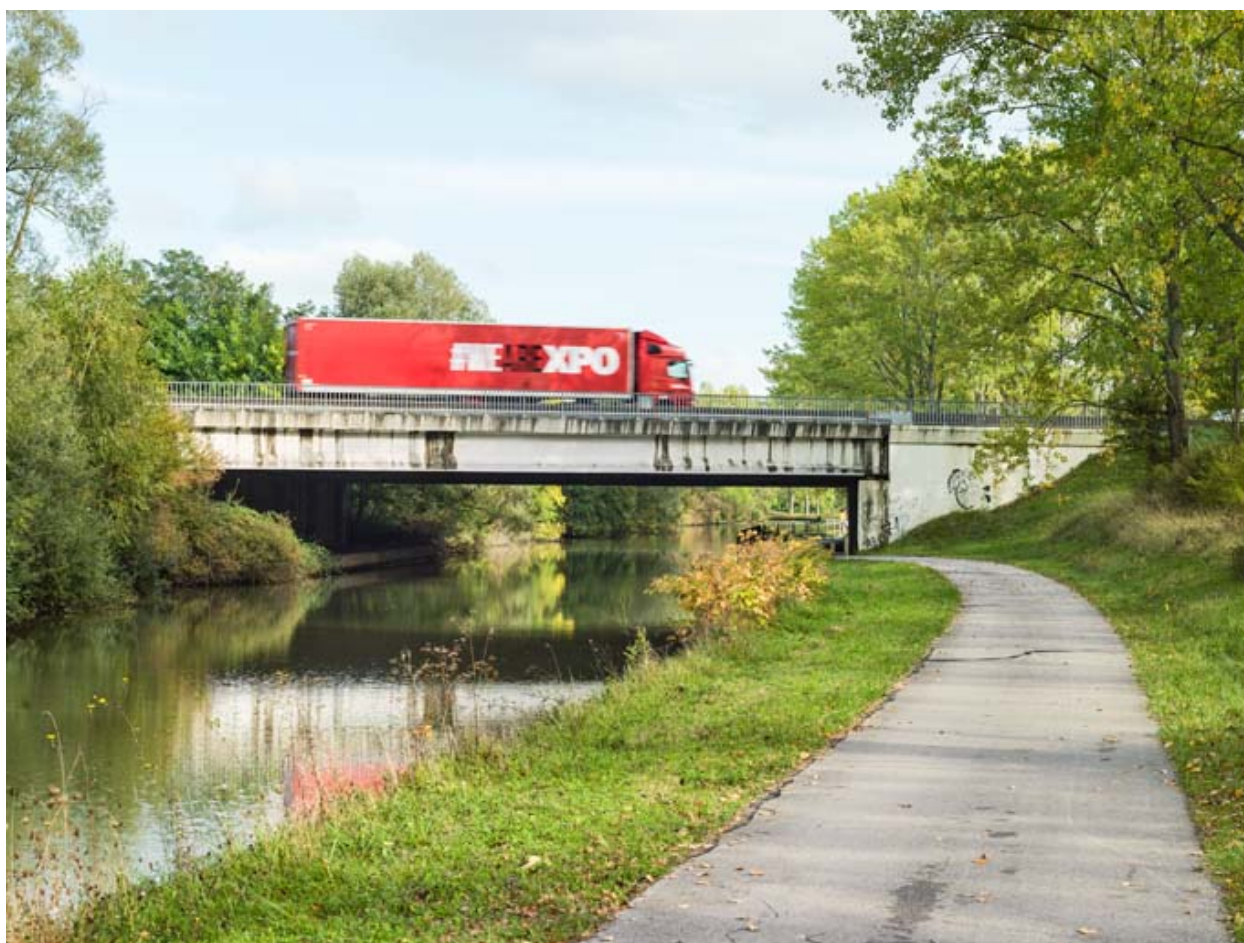
Vue d'ensemble du pont.
