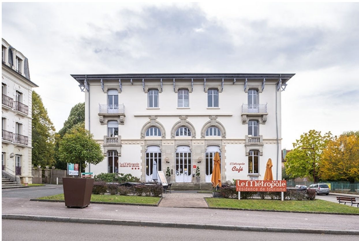
Façade nord, vue de face.
