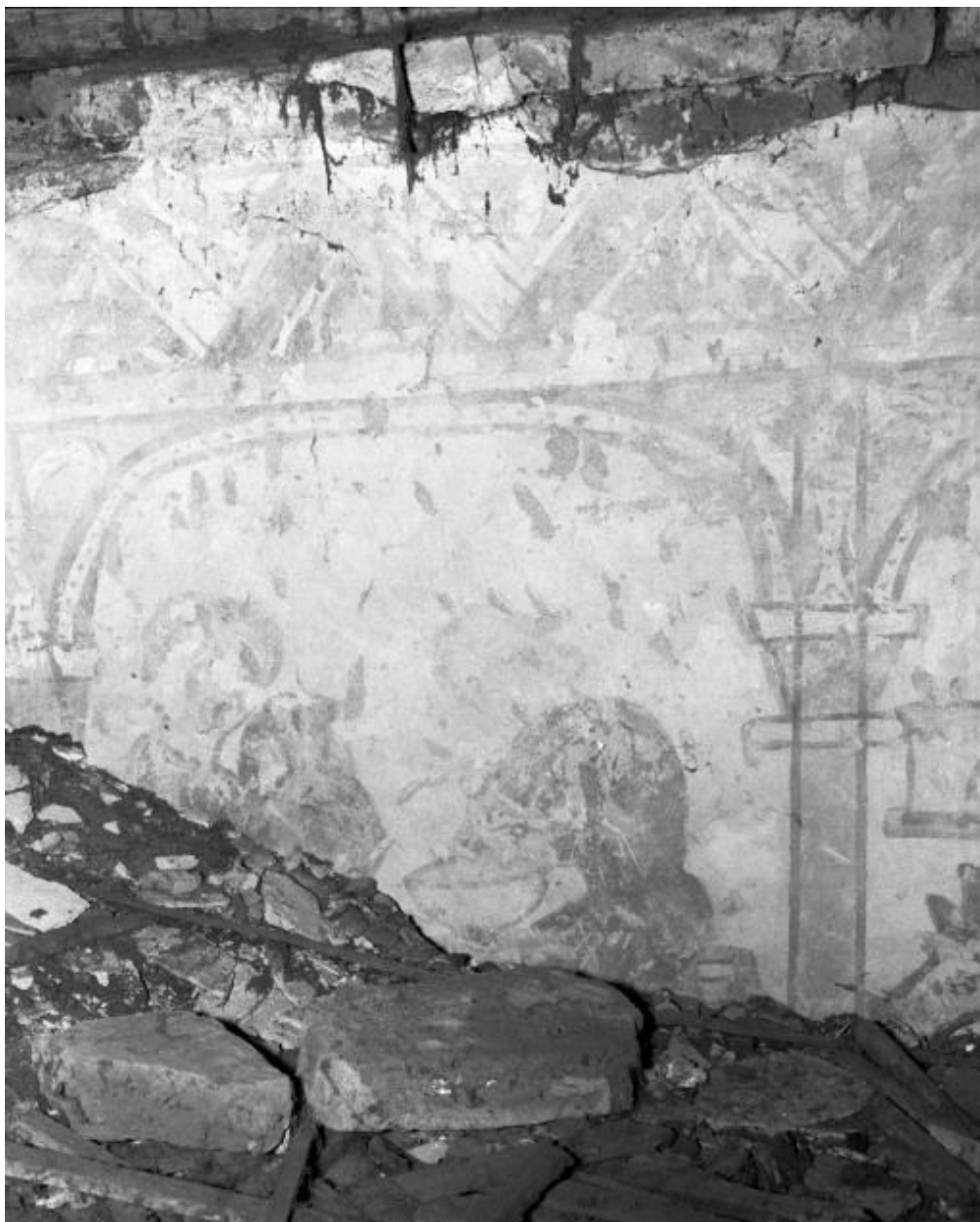
Comble de la nef, mur droit
