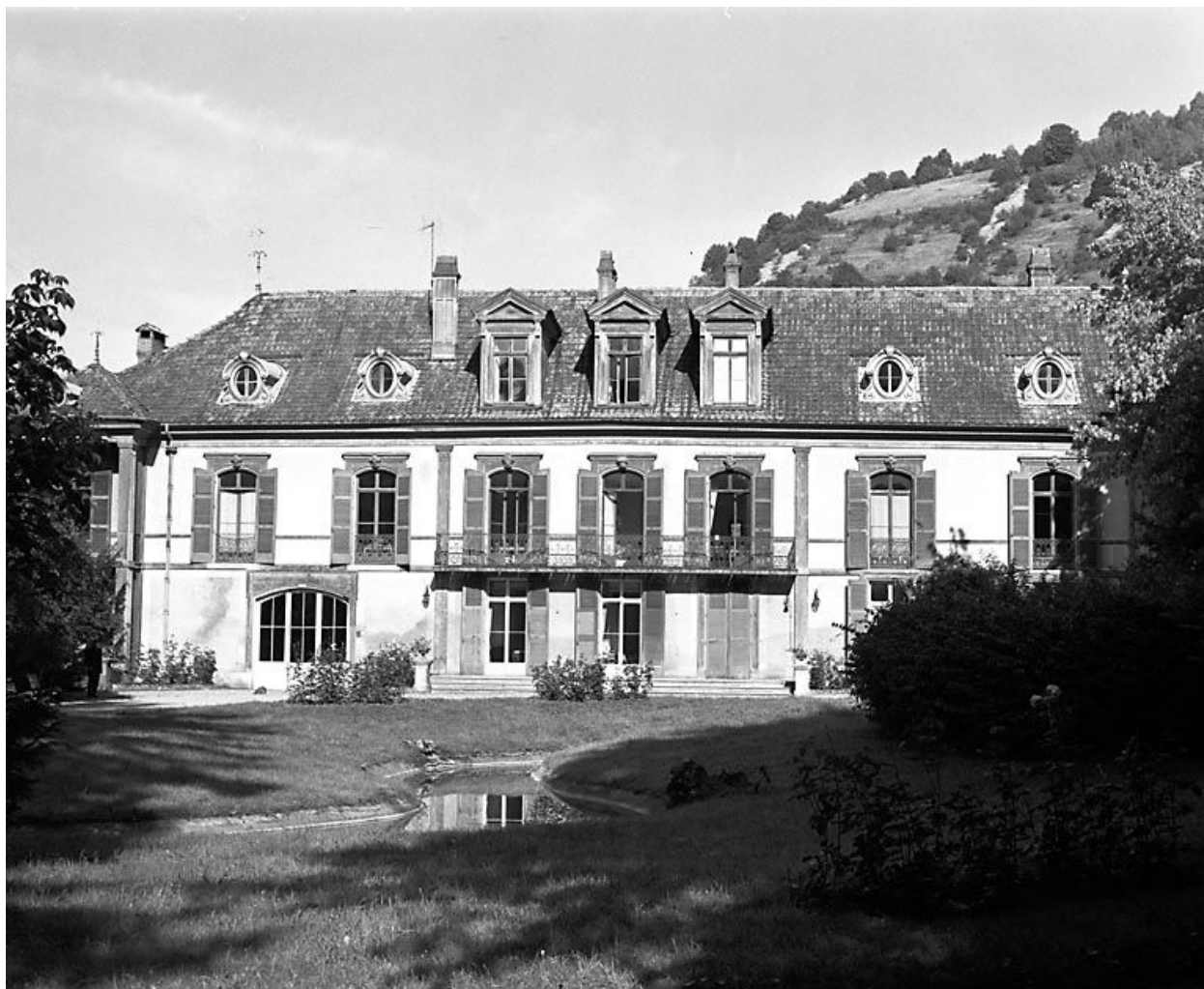
Façade postérieure vue depuis le parc.
