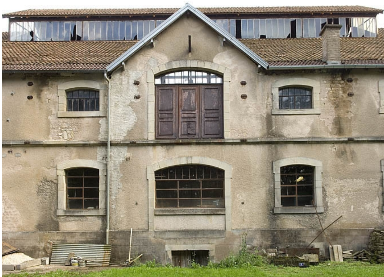
Travée centrale de la façade postérieure.
