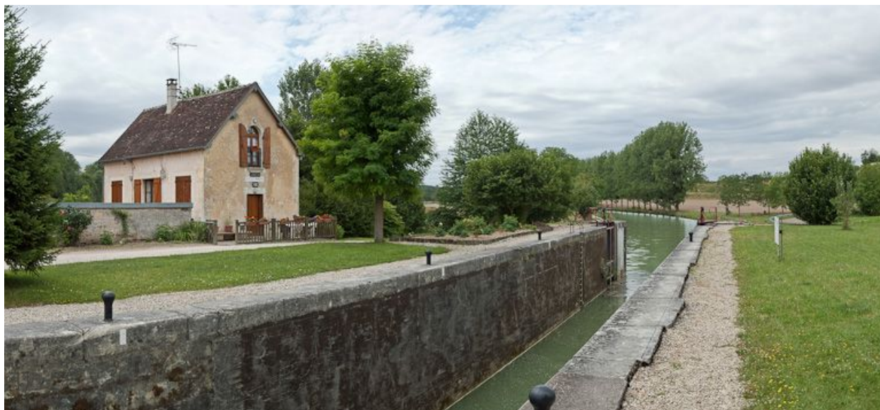
Vue d'ensemble du site d'écluse.
