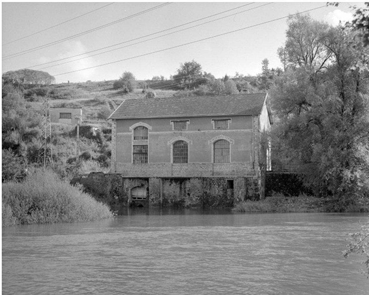
Façade postérieure de la centrale.
