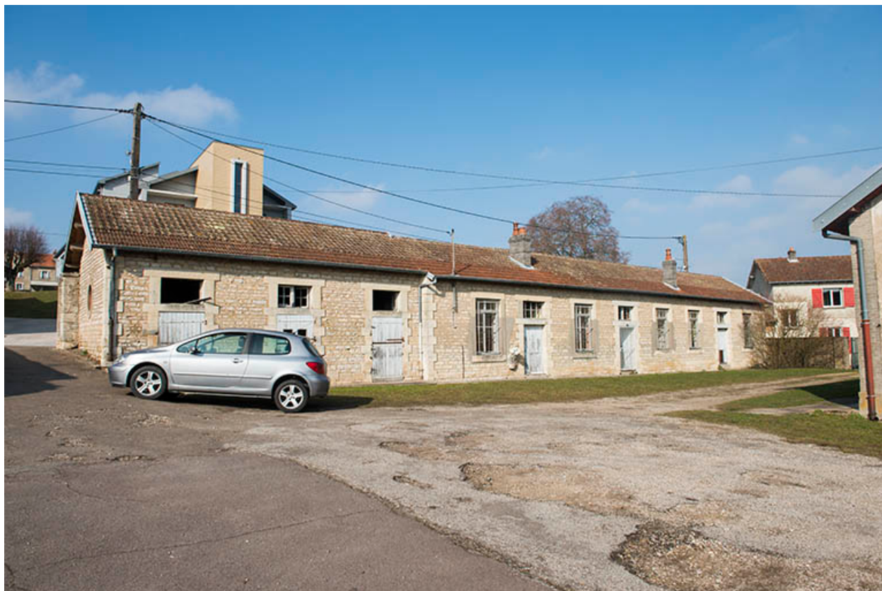
Cou" Au bas de la caserne" : façade sud-est de la barre de logements et écuries, vue du sud-ouest.
