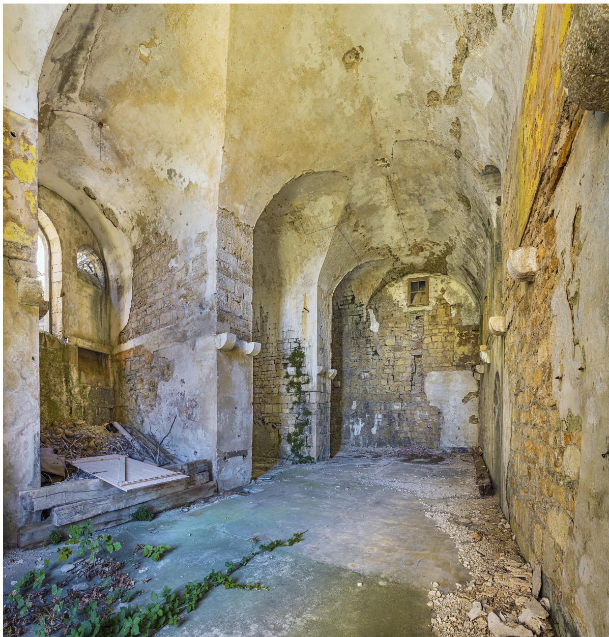
Vue intérieure du bâtiment casematé.
