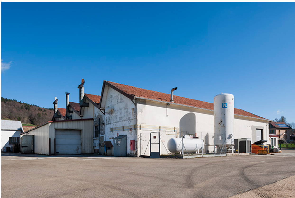
Extension sud de l'usine (1960).
