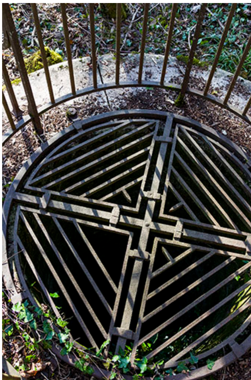
Grille de protection posée sur la margelle.
